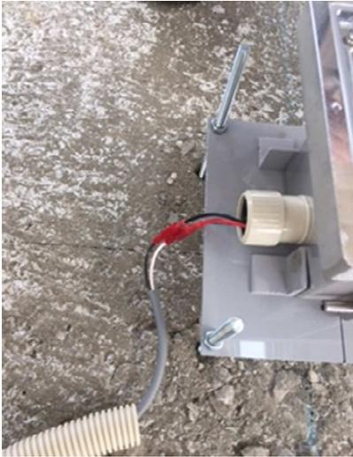
① 配管を取り回し(PF22)、配線を入線する(VCTF1.25x2C)
