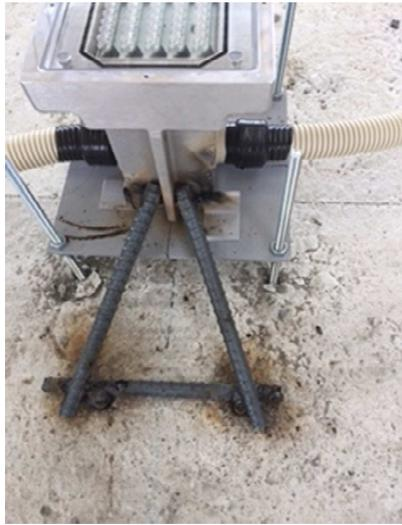
① レベルを出し、溶接アンカー鉄筋棒で固定する
